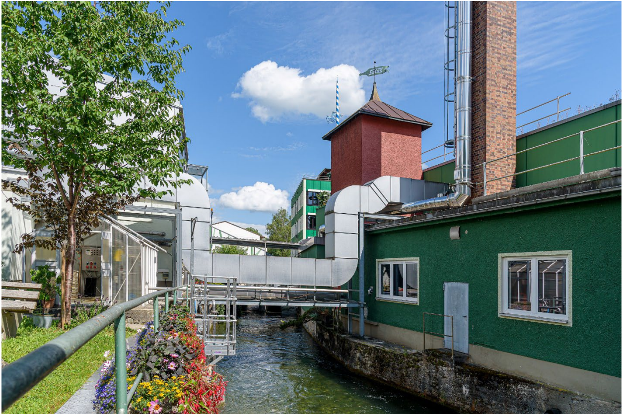
Der Triftbach fließt mitten durch das Salus Gelände und wird zur regenerativen Stromerzeugung genutzt.
